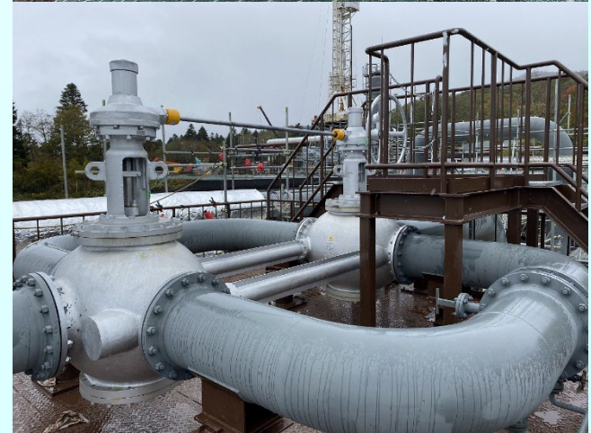
配管設置状況
