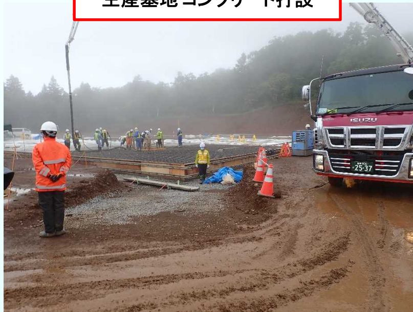
生産基地 コンクリート打設
