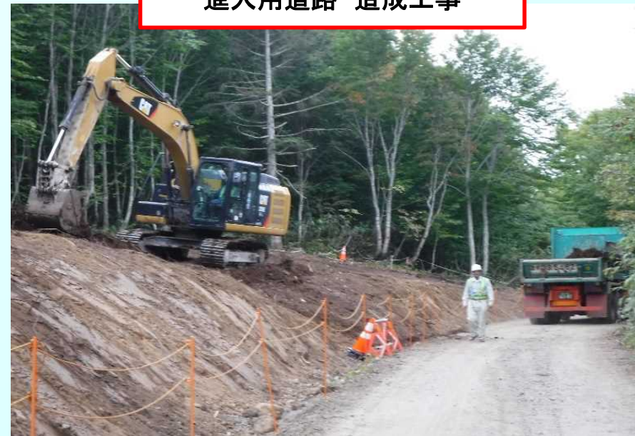
進入用道路 造成工事
